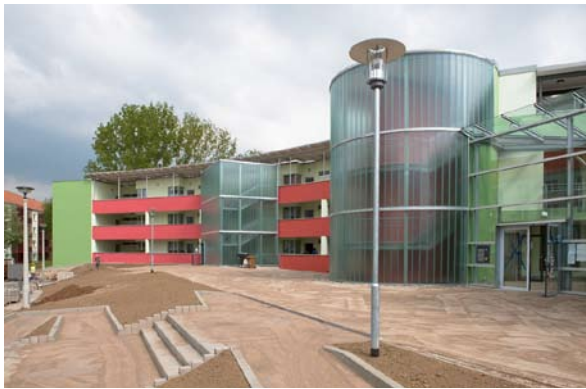
Neubau des Mehrgenerationenhauses in Sangerhausen (Mansfeld-Südharz).
