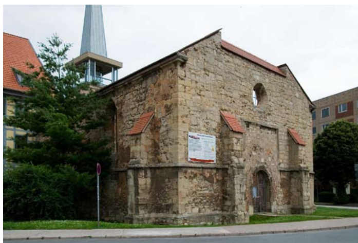
Gemeinsam Neues schaffen: Umbau der Cruciskirche in Sondershausen zum Bürgerzentrum.
